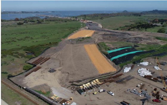
Viaducto Costanera Hualpén
