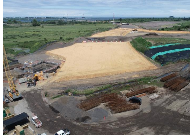
Terraplenes Sector A Hualpén
