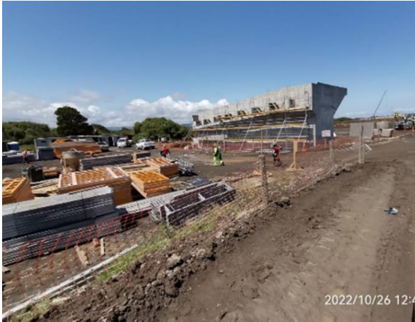
Estribo de Salida - Puente Bocatomá
