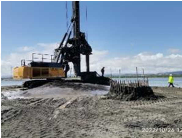
Pilotea en Cepa 22 Puente Industrial
