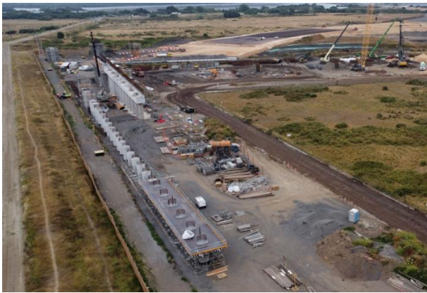
Viaducto Costanera-Hormigonado Cabezal
