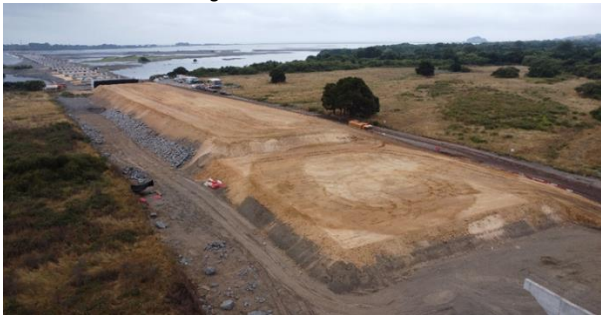
Terraplenes DM 1580-1820-Sector A
