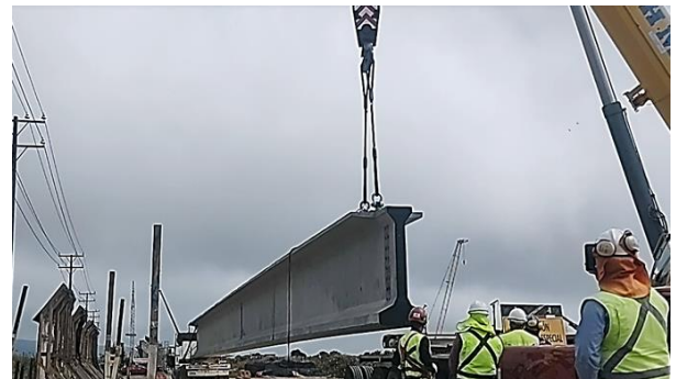
Descarga de viga en obra
