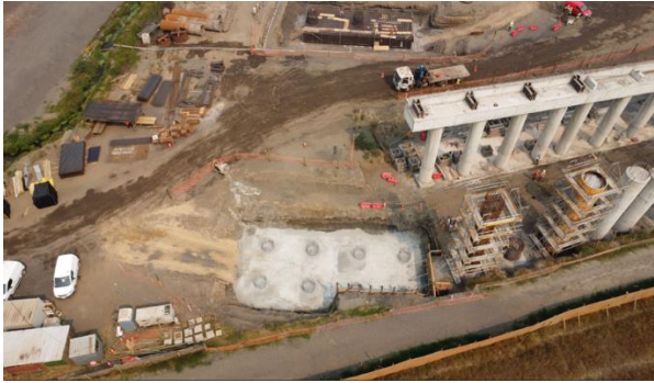
Cepa 4 Viaducto Hualpen
