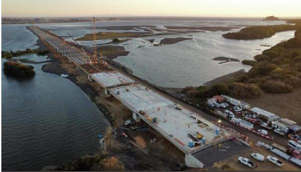
Montaje de prelasas y losa hormigonada en Península-Sector B
