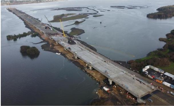
Montaje de prelasas y losa hormigonada en Península-Sector B
