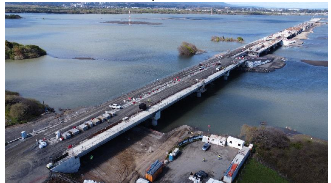
Avance puente industrial Sector B(Península)
