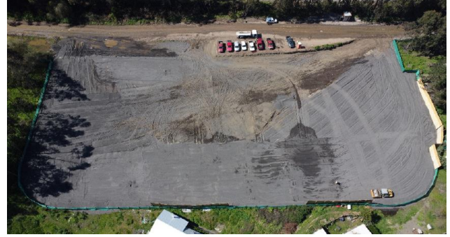
Zona edificio de control –Sector C
