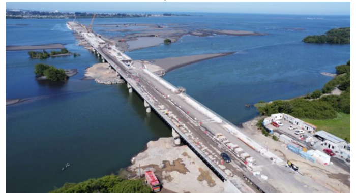
Avance puente industrial Sector B(Península)
