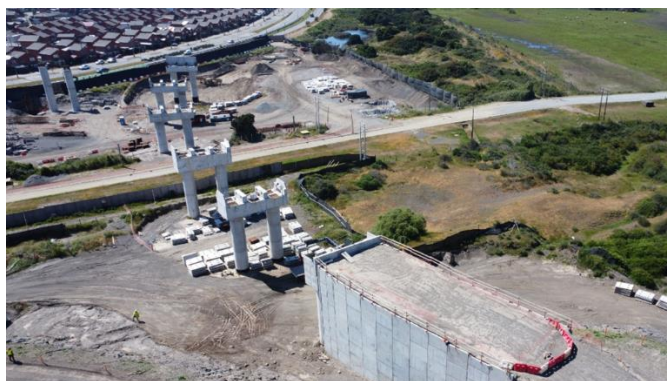
Viaducto Costanera -Sector A
