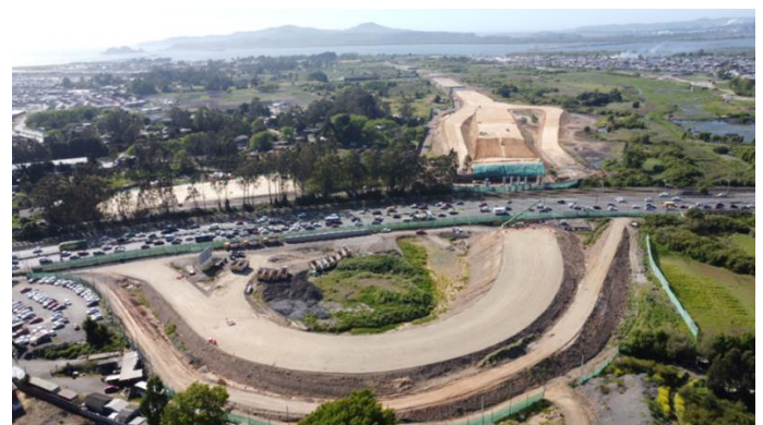
Vista desde enlace -Sector C
