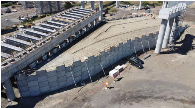
Viaducto Costanera – Sector A
