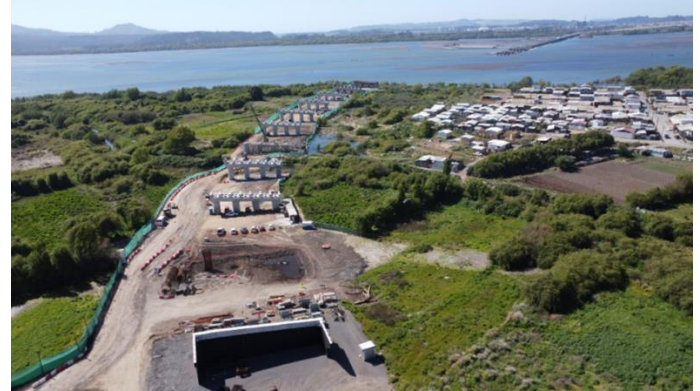
Pilotes sector C, desde estribo salida
