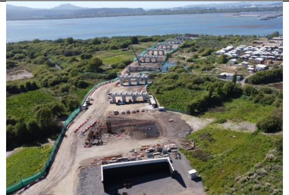
Pilotes Sector C San Pedro
