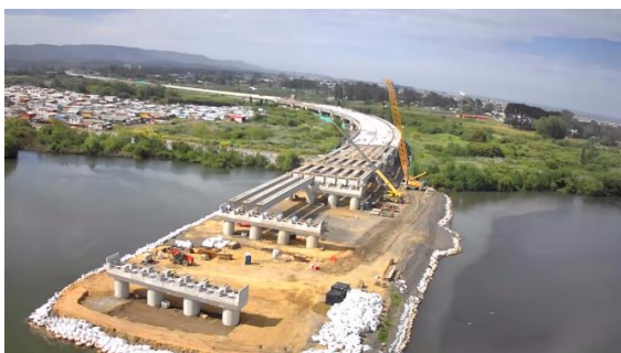
Trabajos en ribera sur – San Pedro de la Paz
