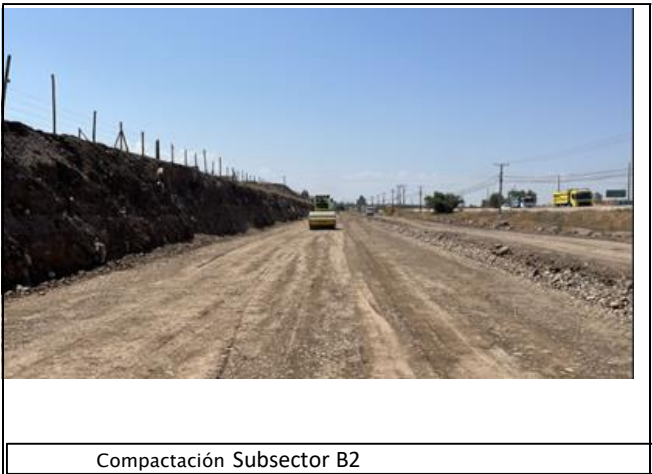
Compactación Subsector B2
