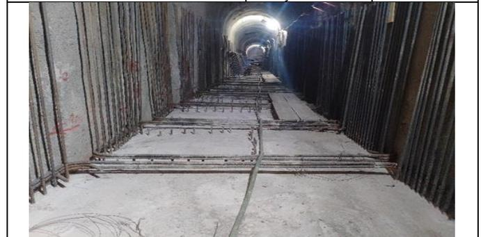
Frente 8 Túnel alemán Galería lateral poniente, hormigonado hastial, hasta nivel Z2.
