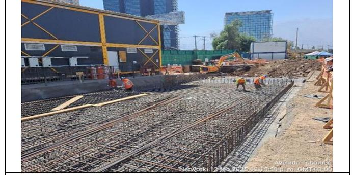
Frente 1 Ramal Tobalaba poniente: Colocación de armadura losa Trinchera cubierta
