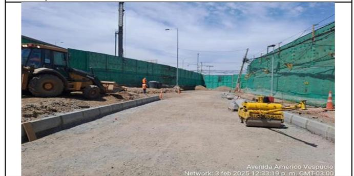
Tramo 3: Reposición calle Exequial Figueroa, colocación de soleras y base estabilizada
