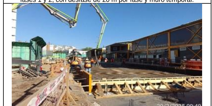
Frente 1, Trinchera Ramal Entrada Tobalaba poniente, Hormigón losa superior trinchera cubierta.
