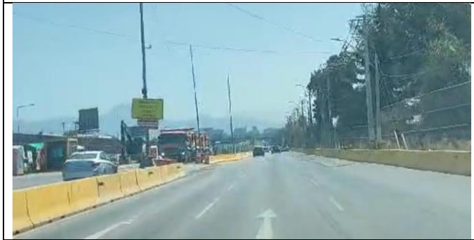
Desvío de tránsito TEO
