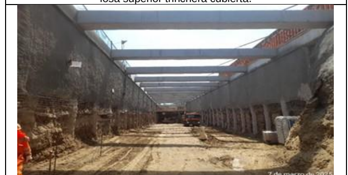
Frente 6, Escotilla Vespucio Sur: Vista panorámica de excavación en sector sur norte.
