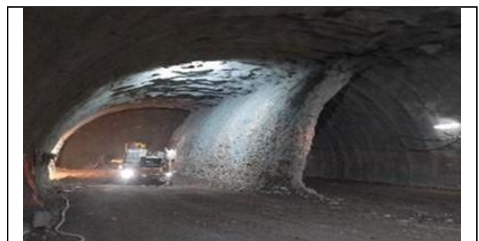
Frente 1 vía expresa poniente, túnel 4 carriles grava, Avances por fases 1 y 2, con desfase de 20 m por fase y muro temporal.
