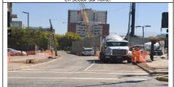
Tramo 3: Reposición de pavimento asfáltico de la calle Exequiel Figueroa.
