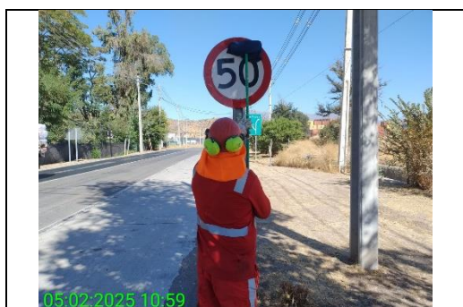
Mantenimiento y conservación de señales verticales
