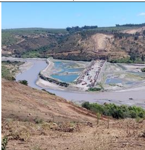
Viaducto Maipo, Dm 125.340 - Dm 125.500
