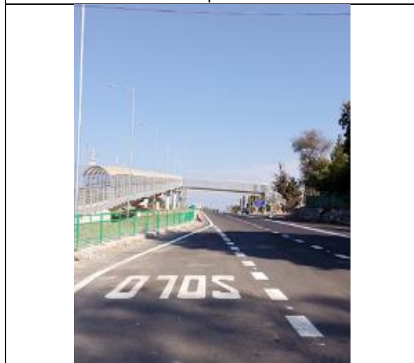
Pasarela Escuela G-139, Dm 101.200
