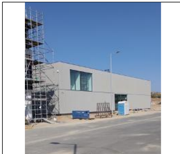
Edificio de administración en Área de Servicios
