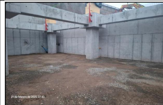
Rellenos de mejoramiento bajo radier
