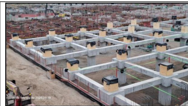
Inicio de Instalación de aisladores sísmicos
