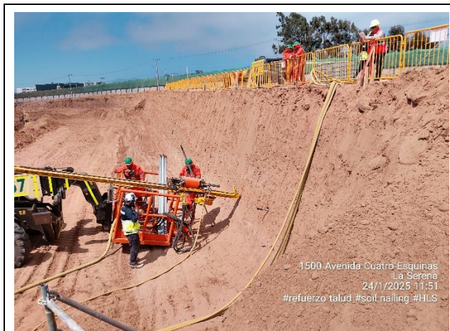
Refuerzo de Taludes (Sistema Soil Nailing)
