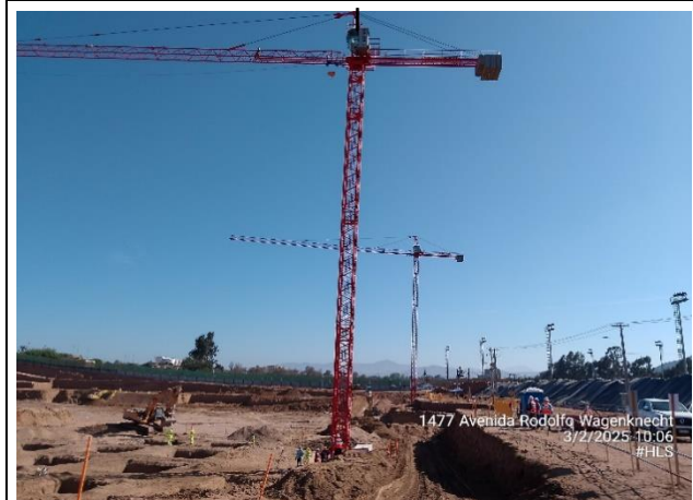
Montaje de Grúas Torre
