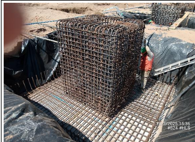
Armadura de Refuerzo en Pedestales (Sector F)
