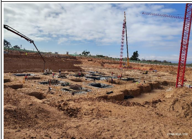
Preparación Sellos de Fundaciones Aisladas (Sector F)
