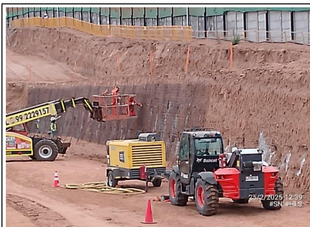
Refuerzo de Taludes (Sistema Soil Nailing)
