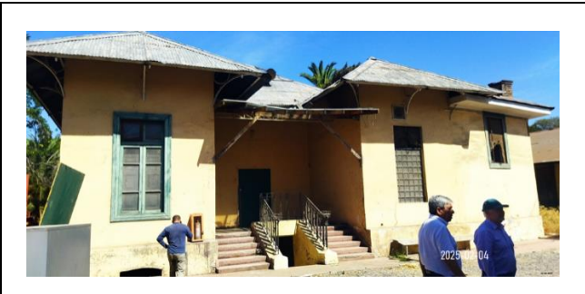
Imagen N°1: 04.02.205 visita a terreno de especialistas de la AIF, con el motivo de corroborar en terreno la factibilidad del traslado de la Subestación eléctrica que abastece al área no concesionada (área patrimonial)
