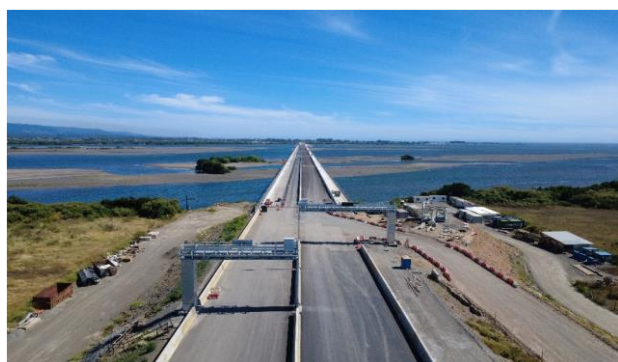
Sector A - Pórticos en sector B (Hualpén)
