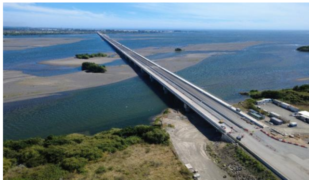
Sector B - Vista del puente desde Hualpén
