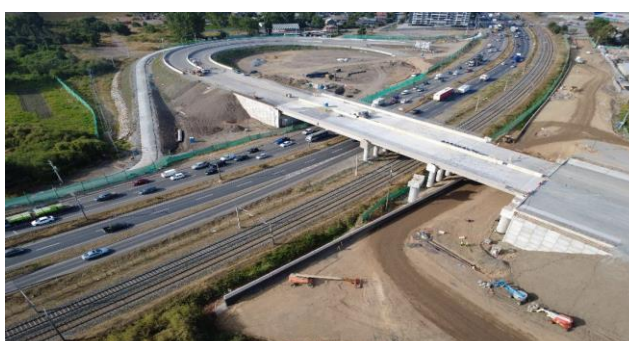
Sector C – Viaducto Los Batros – San Pedro de la Paz
