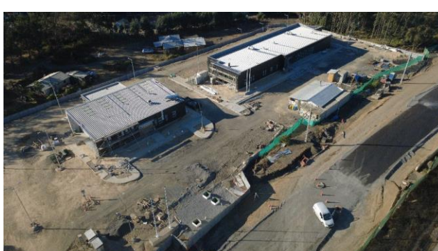
Sector C - Edificio de Control y áreas de emergencia
