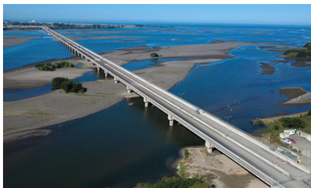
Sector B – Puente Industrial
