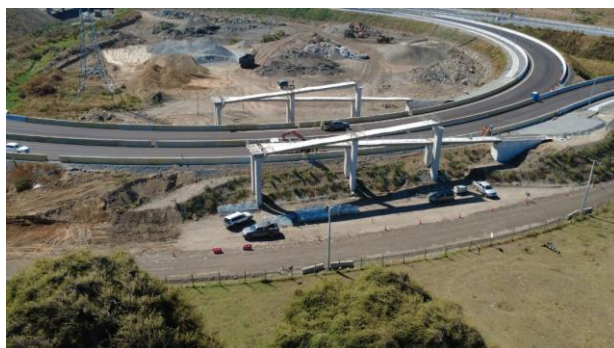
Sector A – Pasarela Peatonal N° 1 - Hualpén
