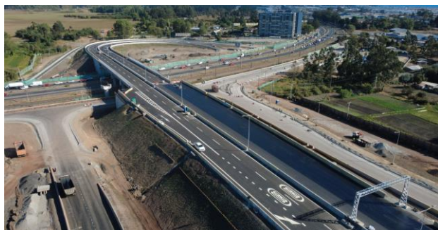
Sector C – Viaducto Los Batros – San Pedro de la Paz
