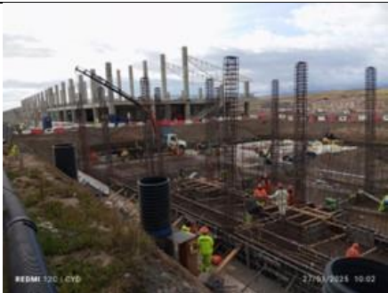
Excavación masiva Área de estacionamientos
