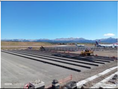
Hormigonado de la plataforma de movimiento de aeronaves PMA
