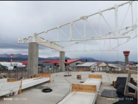
Armado y montaje de prueba de Estructuras Metálicas
