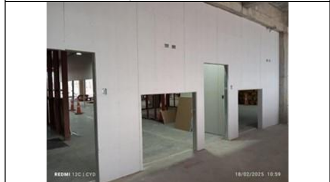
Colocación de perfilera galvanizada
