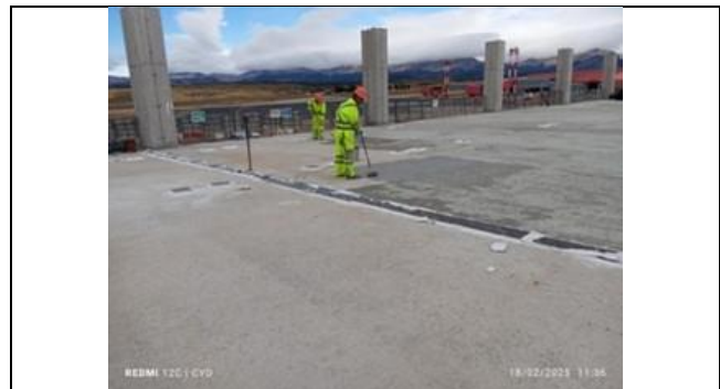
Reparación Obra Gruesa, sellado de fisuras por retracción y juntas en losas.
