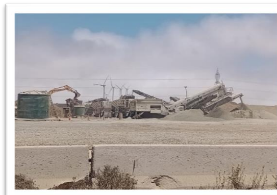
Foto 5: Ruta 5, Km 306, Planta de chancado, preparando material para mezclas asfálticas.
