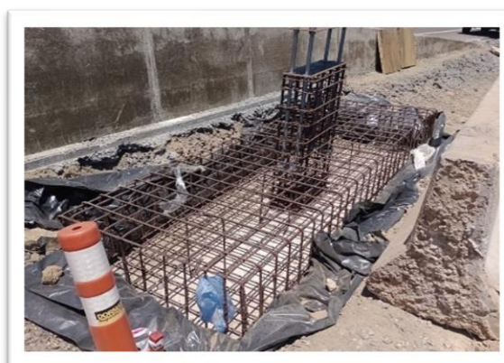
Foto 4: Ruta 5, Km 283 sector interurbano, enfierradura para pórtico.
