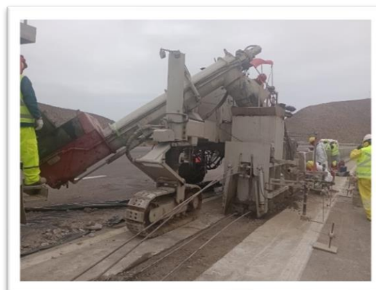
Foto 3: Ruta 5, Km 325, Sector el teniente, preparación equipo barrera de hormigón, se destaca sección del moldaje.
