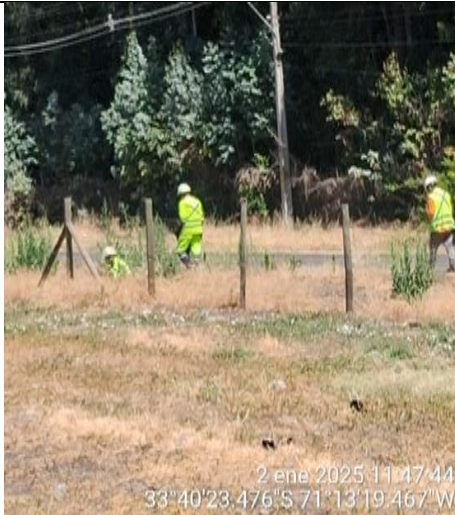
Limpeza de faja Fiscal CSD km. 68+100
