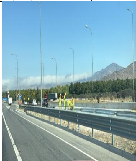
Instalación de defensas doble onda Km. 21+700
