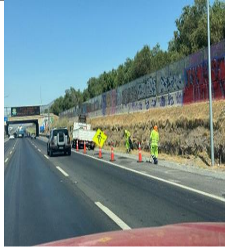
Limpieza y mantención de faja km. 12+000
