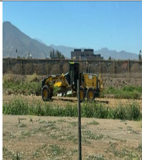
Roce Mecanizado km. 64+700
