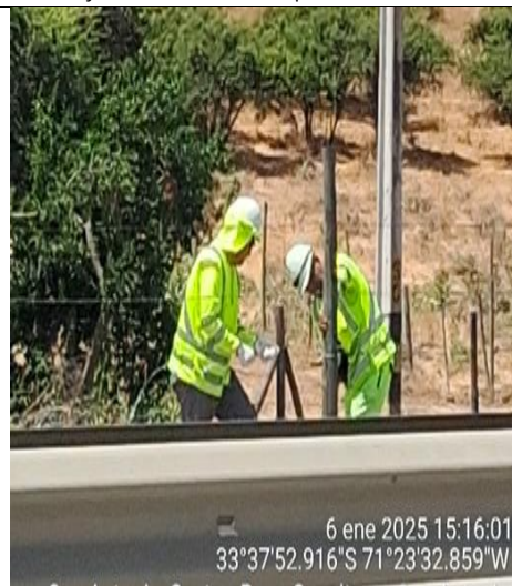
Mantención de cercos km. 85+600
