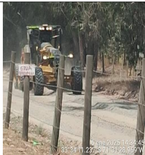
Mantención de Calle de Servicio Izquierda km. 100+200
