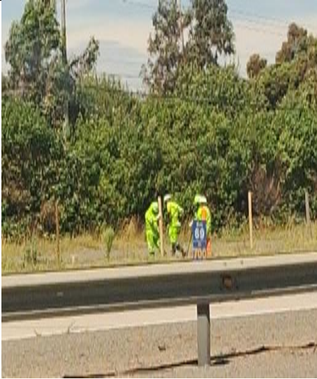
Reparación de Cercos km. 69+700
