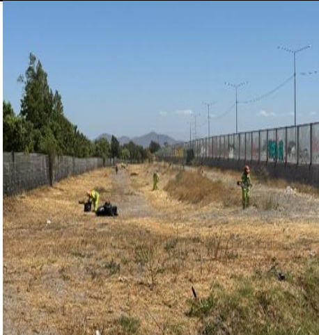
Limpieza y mantención de faja descendente km. 16+600
