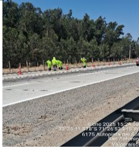
Limpieza de Cunetas km.91+280
