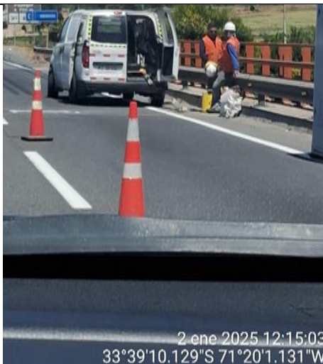
Reparación de Juntas de Dilatación Puangue- km.79+280
