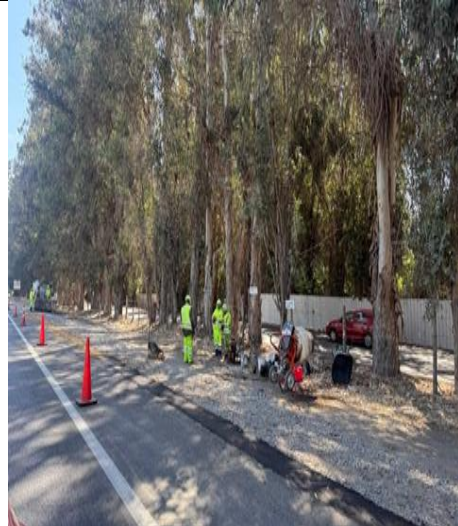
Reparación de bermas Km. 42+900
