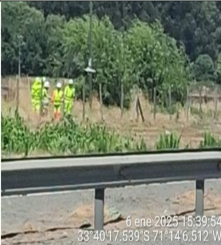
Limpieza Soleras km. 81+100-
