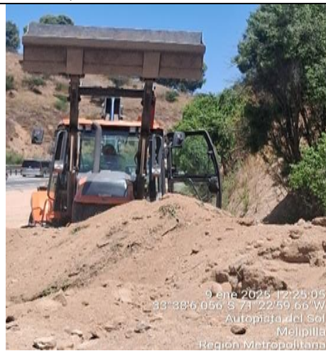
Retiro de material- Sepultura km. 84+660
