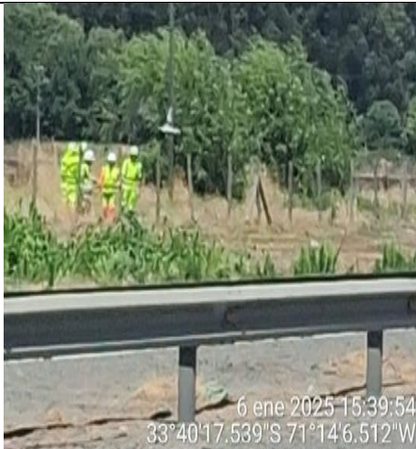
Reposición de cercos -km. 67+700
