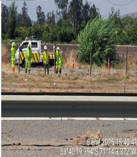
Reparación de cercos Km.69+200
