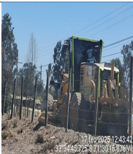
Reperfilado de CSD km. 97+500
