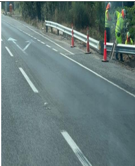
Limpieza y mantención de faja Km. 56+500
