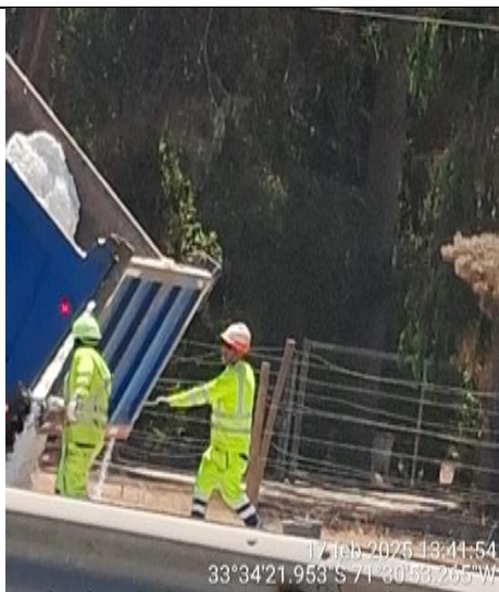
Colocación de bischofita CSD km. 101+000
