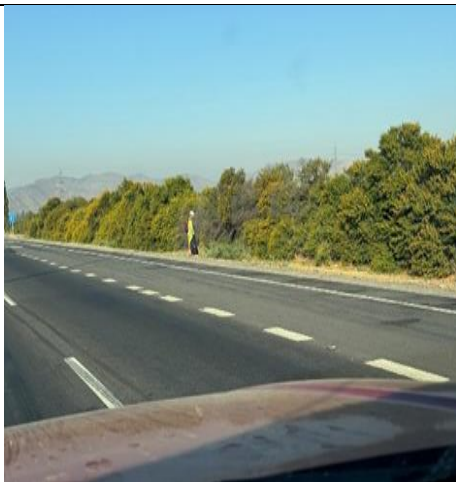
Limpieza y mantención de faja - km. 22+700
