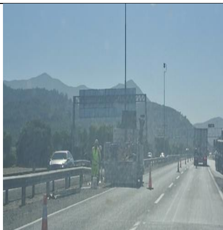
Limpieza de Mediana km. 61+600
