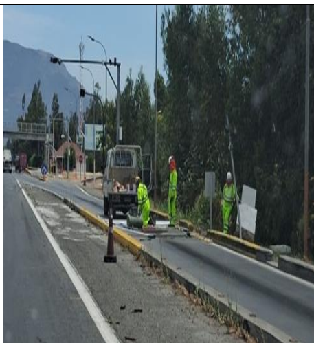
Mantenimiento Plaza de Pesaje km.46+150- Ascendente
