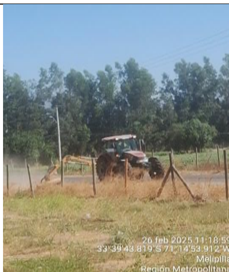
Roce con tractor desbrozador-CSD km. 70+900
