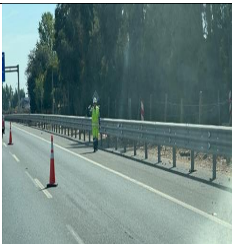
Limpieza y mantención de faja descendente km. 30+600
