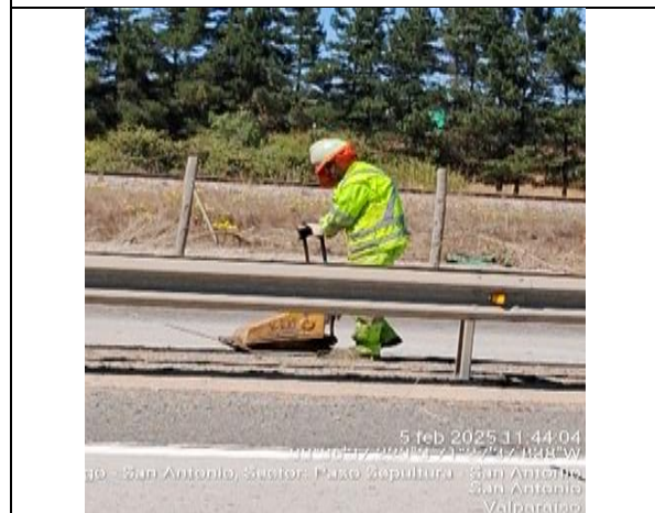
Bacheo en berma interna km.92+500
