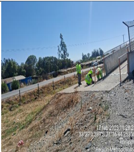
Reparación de Pasarela 74B km. 74+230
