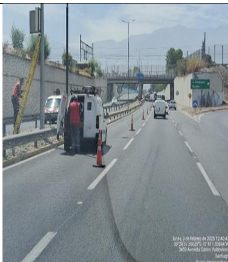
Mantenimiento de luminarias -km. 2+700
