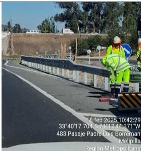
Reparación de defensa km. 67+100-
