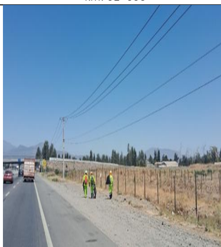
Limpieza de faja km. 32+080
