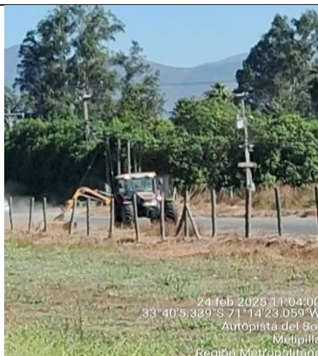
Roce con tractor desbrozador-CSD km. 70+000
