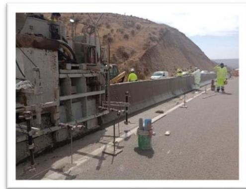
Foto 2: Ruta 5, km 369, Barreras de hormigón sector Alcones y Socos.
