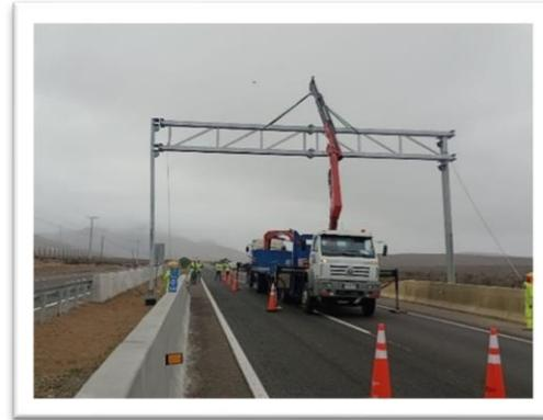
Foto 1: Ruta 5, km 282, Señal vertical, montaje de pórtico.
