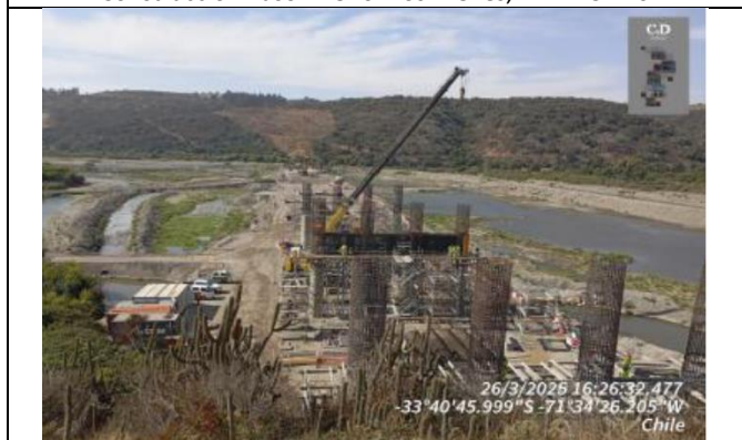
Construcción Viaducto Maipo, Dm 125.309
