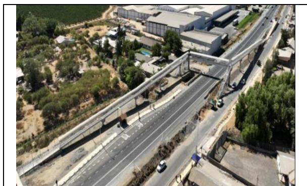
Pasarela Peatonal Santa Inés
