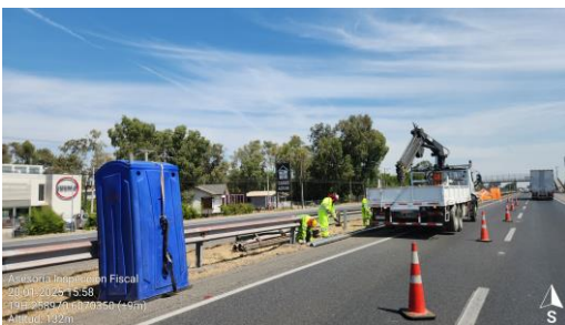
Dm 258.040 – Instalación defensas metálicas en mediana.
