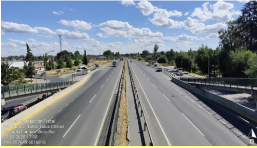
Dm 315,920 – Panorámica Vista Sur Pasarela Longavi.
