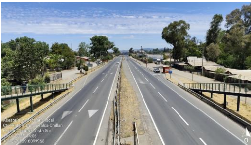
Dm 221,830 – Panorámica Vista Sur Pasarela Camarico.
