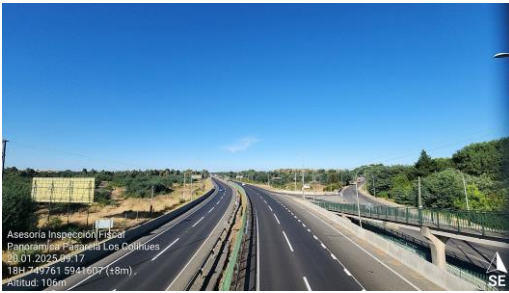
Dm 412.167 - Panorámica Pasarela Nebuco.
