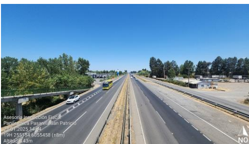
Dm 274.930 - Panorámica Pasarela San Patricio.
