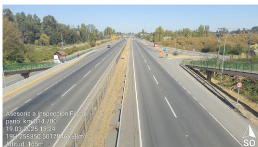
Dm 314.675 – Panorámica Pasarela Cerrillos.
