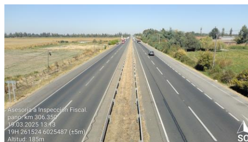
Dm 306.354 – Panorámica Pasarela La Aguada lado Norte.
