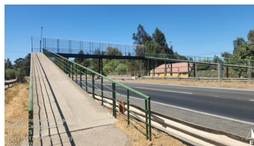
Dm 221.830 – Panorámica Pasarela Camarico.
