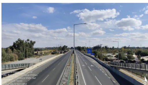
Dm 321,212 – Panorámica Vista Sur Pasarela El Peñasco.
