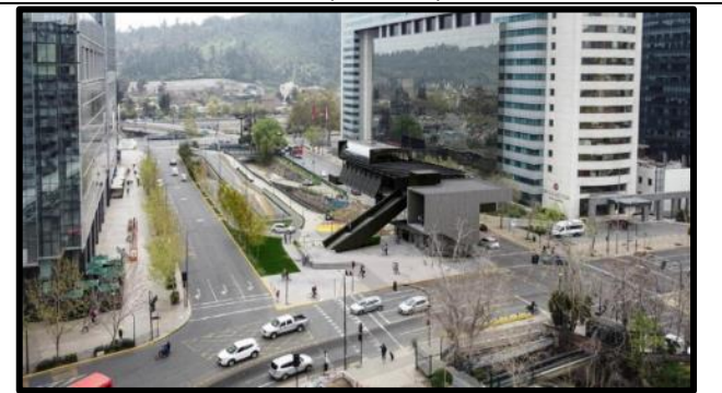
Estación Canal San Carlos
