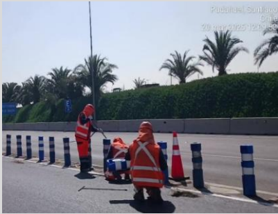
Km. 3,400 Descendente; limpieza sumidero en tramo B1
