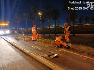
Km. 1.000 mediana limpieza de luminarias Pudahuel, Santiago Chile 12 mar 2025 23:44:00
