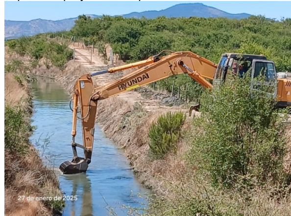
Imagen N°7. Canal El Molino, Km 2+460.
