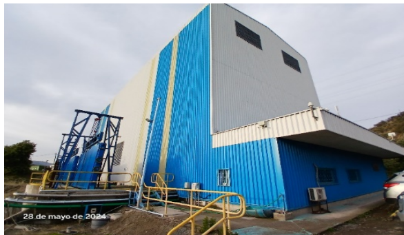
Imagen N°4. Vista general de la Central Hidroeléctrica.
