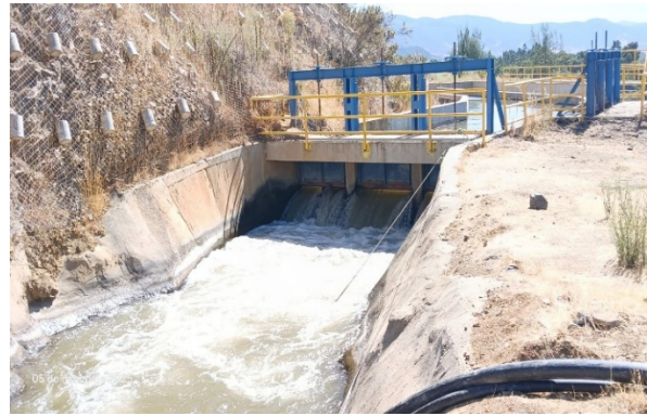
Imagen N°7. Canal Norte, Km 12+200.
