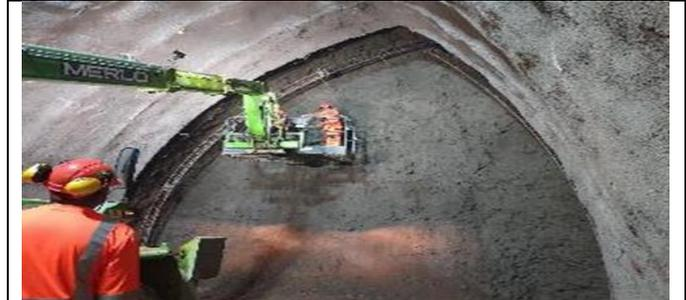
Frente 4 Túnel Vía Expresa Oriente: Avance en dirección norte, sección 3 carriles, por fase 1, instalación de marco.
