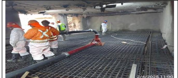
Frente 5 Ramal Los Orientales: Hormigonado vigas de reparto, viga de apeo y losa sala técnica.
