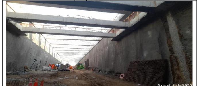
Frente 6: Trinchera entrada en la unión con AVS, elementos estructurales terminados se trabaja en calzada
