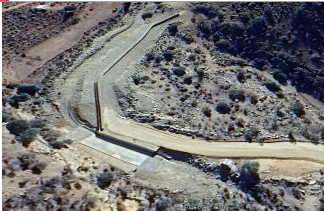
Fotografía N°5, Vista estación de control fluviométrica Frutillar
