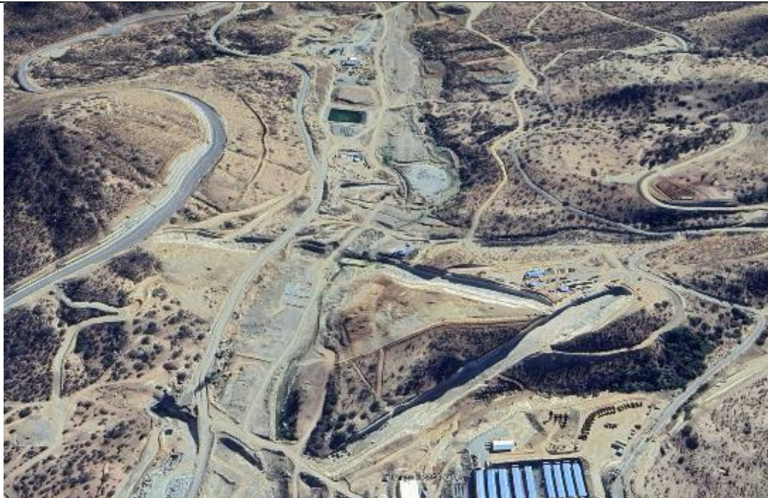
Fotografía N°3, Vista de las obras y campamento
