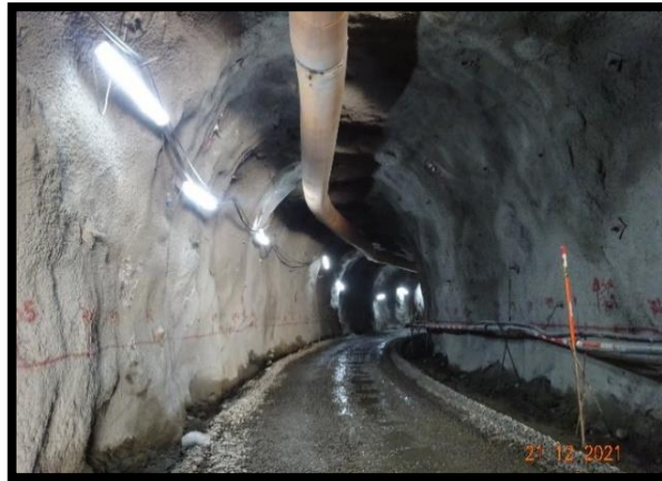
FIG N°6: Vista General Túnel de Desvío – Portal Entrada
