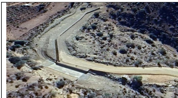
Fotografía N°5, Vista estación de control fluviométrica Frutillar
