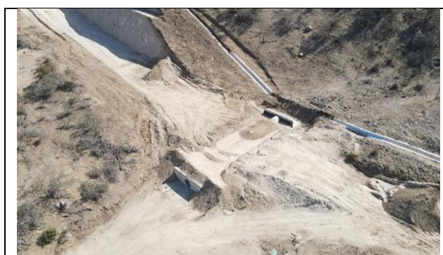
Fotografía N°1, Vista OA N°15. Variante Ruta E-315
