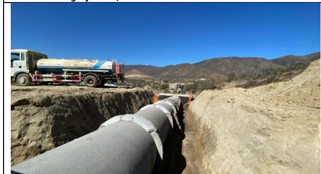
Fotografía N°2, Rellenos estructurales OA N° 21. Variante Ruta E315
