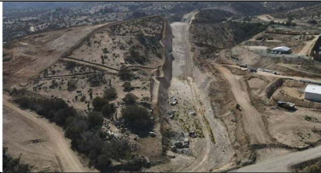
Fotografía N° 12. Evacuador de Crecidas y Rápido de Descarga.
