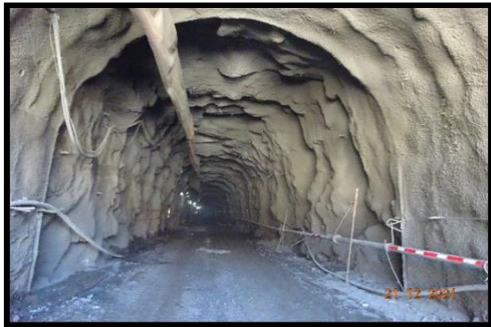
Vista General Túnel de Desvío – Portal Entrada
