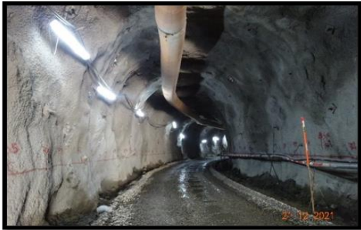
Vista General Túnel de Desvío - Portal Salida
