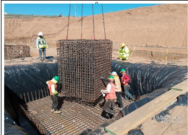
Armadura de Refuerzo en Pedestales (Sector F)
