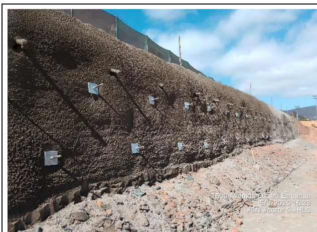
Refuerzo de Taludes (Sistema Soil Nailing)
