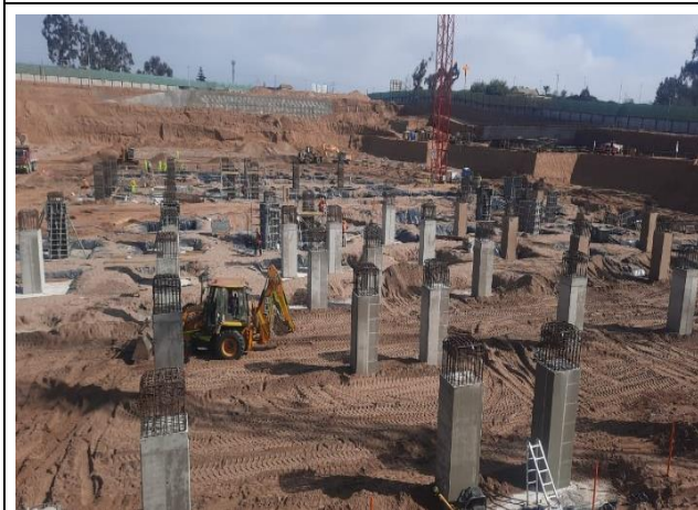
Pedestales Hormigonados (Sectores E-F)
