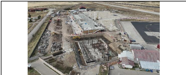
Vista general Aeródromo Balmaceda
