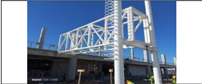
Montaje de Pre- puentes de Embarque
