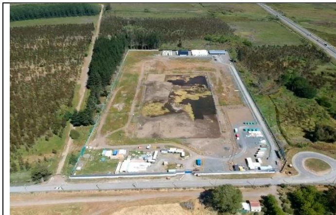
Vista aérea Hospital de Coronel
