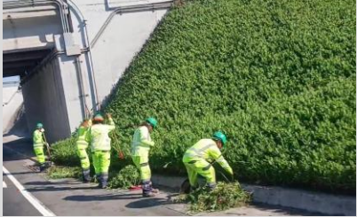
Eje AVAMB, Km. 2,000, sector Terminal de Carga. Labores de mantención de la faja vial y paisajismo del contrato: poda de cubresuelo para el despeje de solera..
