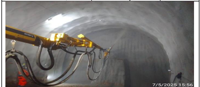
Frente 5 Entrada los orientales: Sostenimiento para el marco M16.
