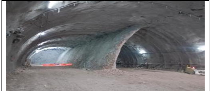
Frente 1 vía expresa poniente sección 4 carriles grava: Avances por fases 1 y 2, con desfase de 20 m mínimo por fase y muro temporal.
