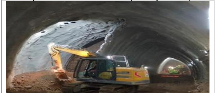
Frente 4: Túnel vía expresa oriente, sección 3 carriles grava, dirección norte, Avance por dos fases y muro temporal.
