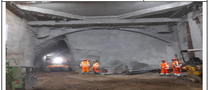
Frente 6 Conexión con AVS, Frente túnel, construcción fase I, obras estructurales terminados, se trabaja en calzada
