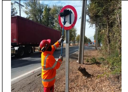
Mantenimiento y conservación de señales verticales
