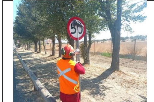
Mantenimiento y conservación de señales verticales
