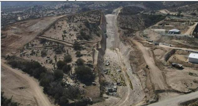
**Fotografía N° 12. Evacuador de Crecidas y Rápido de Descarga.**
