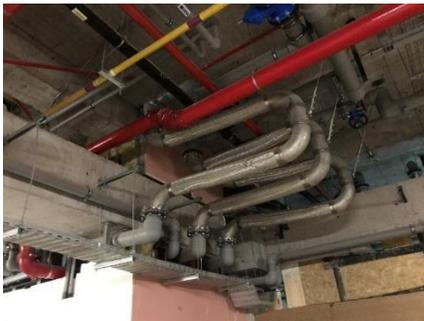
Elementos flexibles de tuberías MEP atravesando la interfaz sísmica.
