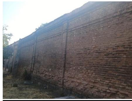
Se observa deterioro en las caras de los ladrillos en sector central e inferior del muro, y deterioro en unión del muro albañilería con su fundación
