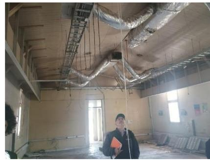
Interior futura Sala Cuna proyectada. Se puede observar que hay diagonales en la unión del pie derecho con la cercha, lo que hace que mejore la rigidez a la deformación transversal del marco
