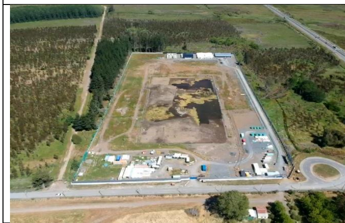
Vista aérea Hospital de Coronel
