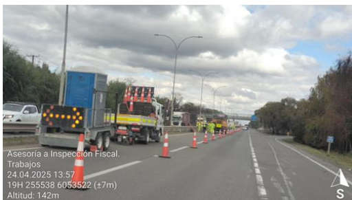
Dm 276,900 – Trabajos Reparación Carpeta Asfáltica Pista 1.
