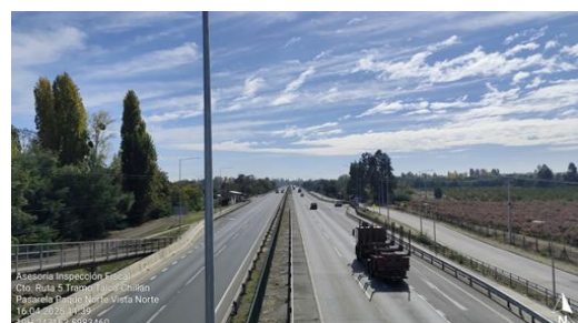
Dm 352,980 – Panorámica Vista Norte Pasarela Paque Norte.
