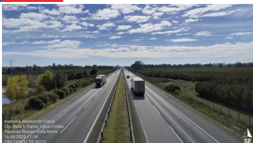
Dm 358,440 - Panorámica Vista Norte Pasarela Ñiquén.
