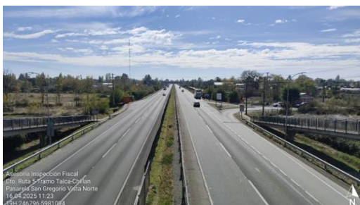
Dm 355,395 - Panorámica Vista Norte Pasarela San Gregorio.
