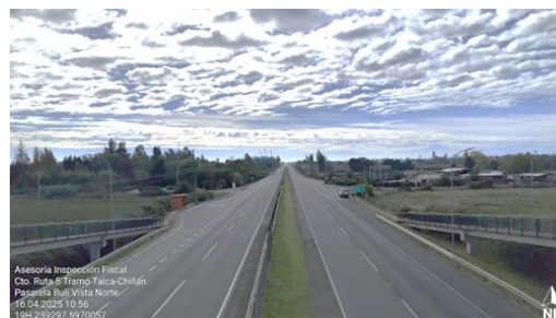
Dm 367,600- Panorámica Vista Norte Pasarela Buli.
