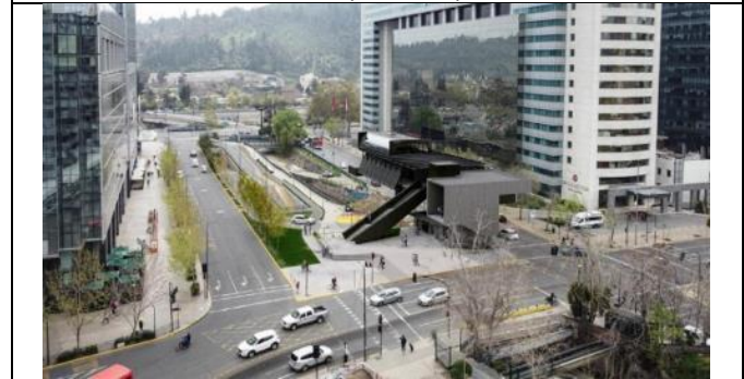
Estación Canal San Carlos
