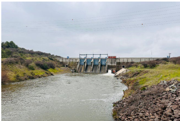
Imagen N°3. Vista general y funcionamiento de la válvula de entrega a riego Howell-Bunger.
