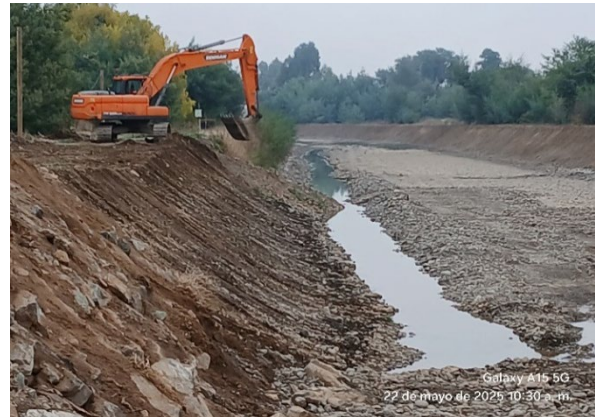
Imagen N°7. Canal San Luis. Restitución de talud lado derecho del canal con maquinaria pesada.
