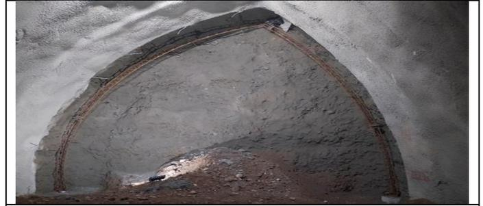
Frente 4: Túnel Vía Expresa Oriente, sección 3 carriles gravas, dirección sur Avance dirección sur, por fase 1, marco instalado.
